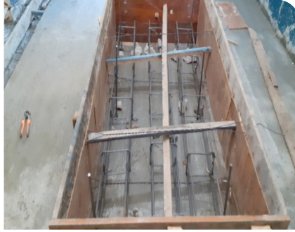
Polydos 412 - լուծույթ պատրաստող Սարքավորման հիմնատակի պատրաստում
