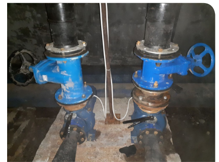
Ֆիլտրերի լվացման ջրամբար ջուր մղող պոմպեր
