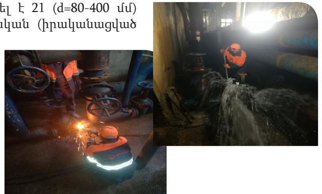
Անսարք փականների փոխարինման և վերանորոգման աշխատանքներ
